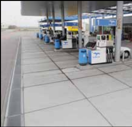
Toepassing Benzinestation Type Stabilo-W plaat 200x200x18,5 cm met koppelrand Opdrachtgever De Meeuw Rilland Plaats Rilland Zeeland
