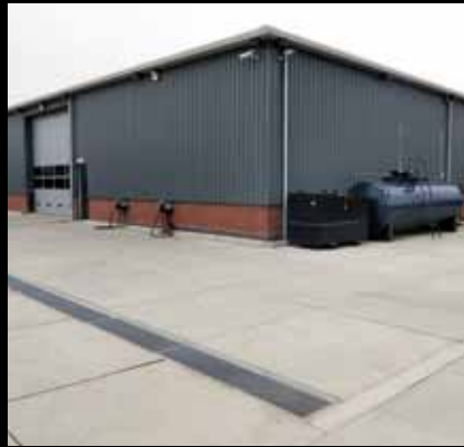
Toepassing Vloeistofdichte verharding ivm dieselpomp Type Bedrijfsmilieuplaat 200x200x18 cm met striprand Opdrachtgever Van der Marel Plaats De Lier
