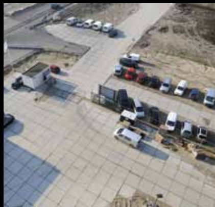
Toepassing Bouwwegen op bouwterrein Type Vloerplaat 200x200x14 cm met hoekrand, constructief gewapend opdrgever Bouwbedrijf Wessels Zeist Plaats Amstelveen
