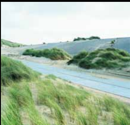
Toepassing Duinovergang Type Vloerplaat 200x200x16 cm met facetrans Opdrachtgever Gemeente Schouwen-Duiveland Plaats Burgh-Haamstede
