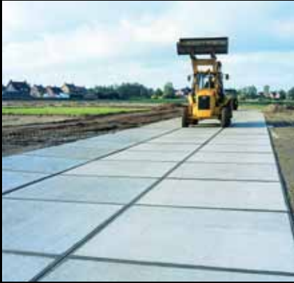
Toepassing Bouwweg Type Vloerplaat 200x200x14 cm met hoekrand, constructief gewapend Opdrachtgever Woningbouwvereniging Plaats Schiedam
