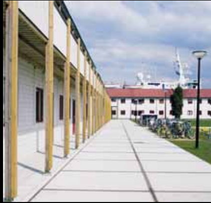
Toepassing Toegangswegen studentenwoningen Type Vloerplaat 200x200x14 cm met hoekrand Opdrachtgever Woningbouwvereniging Rochdale Plaats Amsterdam
