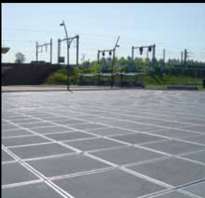
Toepassing Station Breukelen Type Vloerplaat 100x100x14 cm met RVS hoekrand, kleur zwart Opdrachtgever Pro Rail Utrecht Plaats Breukelen
